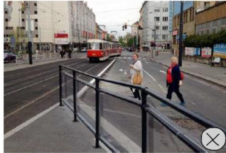
02.078 ^ Недопустимо организовывать ограждение с краю островка так, чтобы оно продолжалось вплоть до путей трамвая; такое решение бессмысленно и снижает безопасность пешеходов весьма сильно [остановка Koh-i-noor, Прага]. #taktone #zabradli #pristupnazastavku #ostruvek #koh-i-noor
